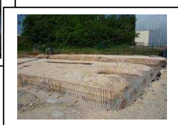
Mai 2009 : les fondations
